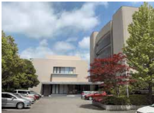
サイバーサイエンスセンター本館（右）、 2号館（左）
