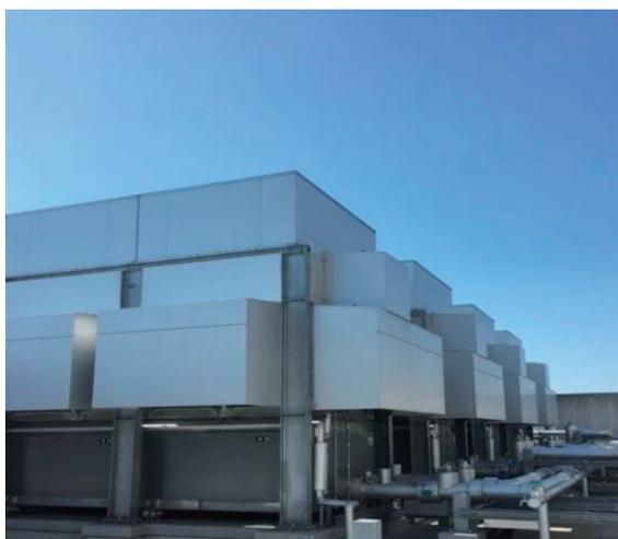
図3 冷却塔一体型チリングユニット
