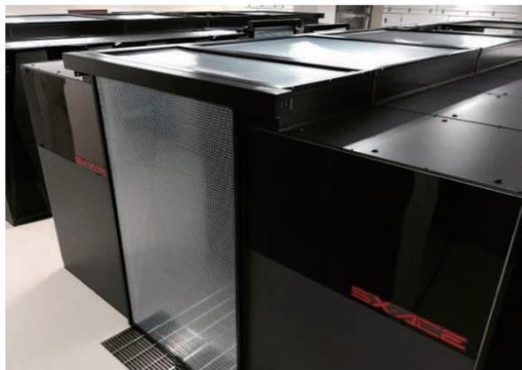
図4 アイルキャッピングを設置したSX-ACE
