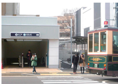
地下鉄東西線 青葉山駅北1出入口
