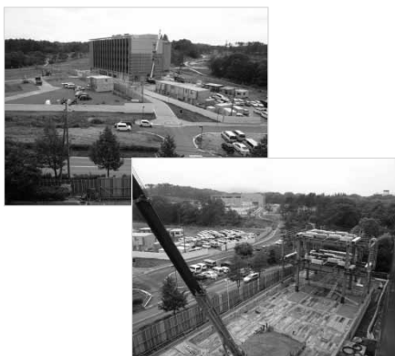
写真上:整備中の青葉山新キャンパス 写真下:センター新棟工事
