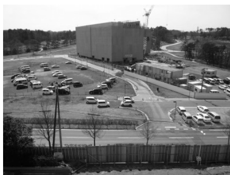
サイバーサイエンスセンター本館前 整備中の青葉山新キャンパス
