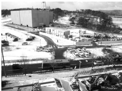
サイバーサイエンスセンター本館前 画面手前：センター新棟工事 画面奥：整備中の青葉山新キャンパス
