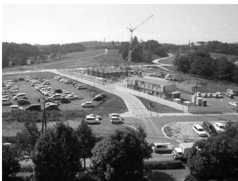
サイバーサイエンスセンター前 整備中の青葉山新キャンパス
