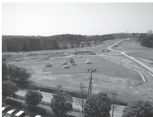
サイバーサイエンスセンター前 整備中の青葉山新キャンパス
