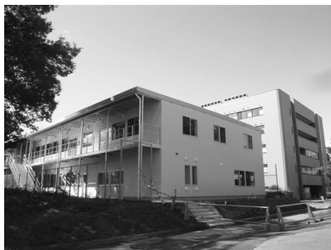
サイバーサイエンスセンター東隣に地震で被災した研究室が入るプレハブの研究棟が完成(平成 23 年 10 月)
