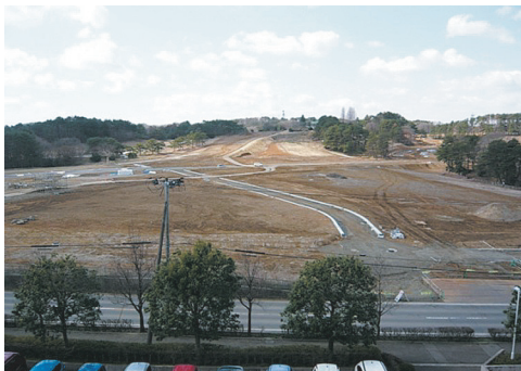
サイバーサイエンスセンター前 整備中の青葉山新キャンパス
